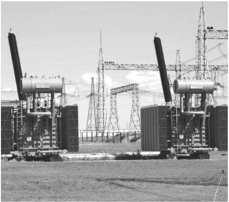
Шунтирующий реактор 500 кВ общей мощностью 180 МВАр производства ТОО «Азия Трафо» (входит в состав АО «Alageum Electric»)
